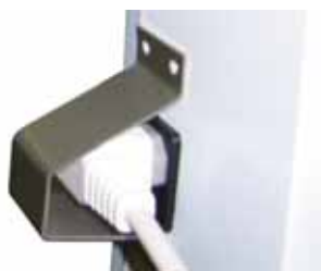
Fig. 10. Beskyttelse over karmvarmestøpset
