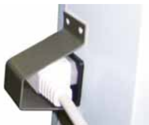
Tekening 10: Deurkader weerstand stekkerbescherming
