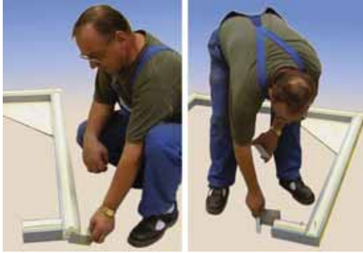
Photo 5. Plaques de recouvrement des angles
