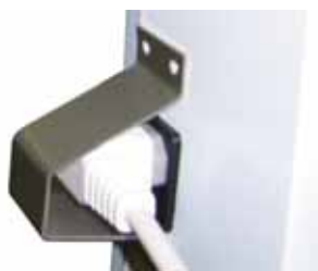
Fig. 10. Beskyttelse over karmvarmestøpset
