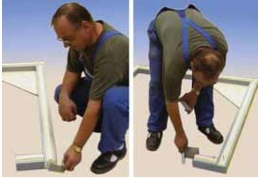
Photo 5. Plaques de recouvrement des angles
