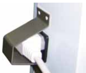
Fig. 10. Beskyttelse over karmvarmestøpset
