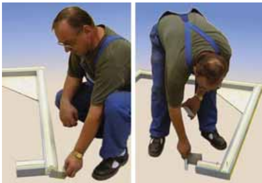
zdj. 5 Instalacja kontowników zdj. 6 L-wspornik
