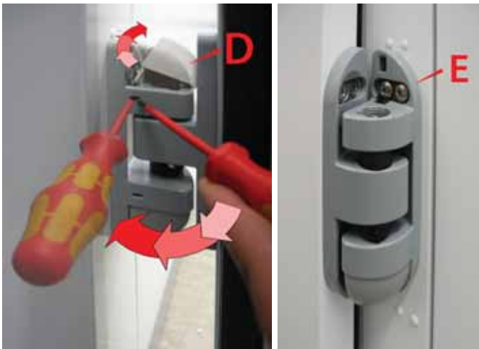
Série de photos 13. Montage des charnières de porte
