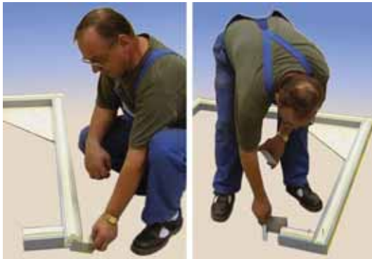
zdj. 5 Instalacja kontowników zdj. 6 L-wspornik
