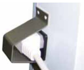
Bild 10. Skydd av karmmotståndets kontakt
