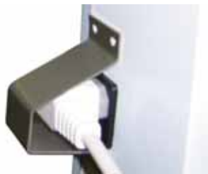
Fig. 10. Beskyttelse over karmvarmestøpselet
