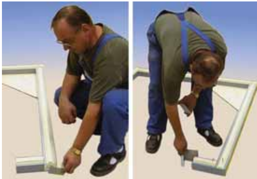
zdz. 5 Instalacja kontowników zdz. 6 L-wspornik
