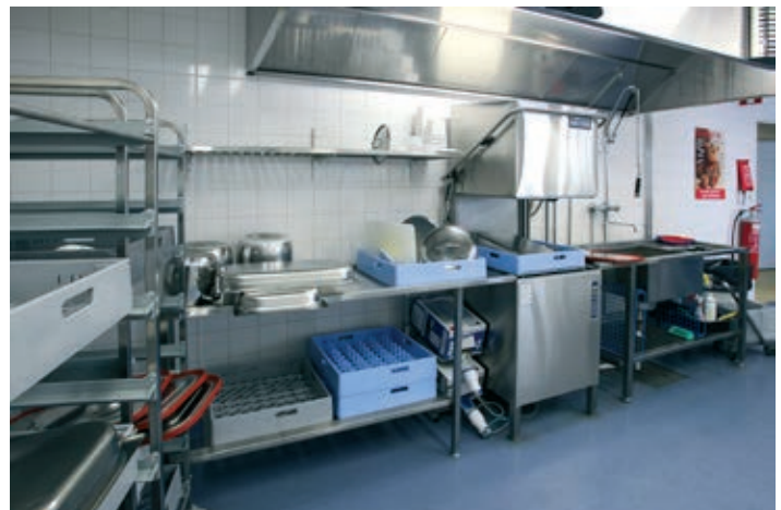
Tuotantokeittiön pesuosastolla on käytössä ympäristöystävällinen Metoksen ICS+ -pesuteknologia. Patapesukoneena on Metos Master GR 300 -raepesukone.
