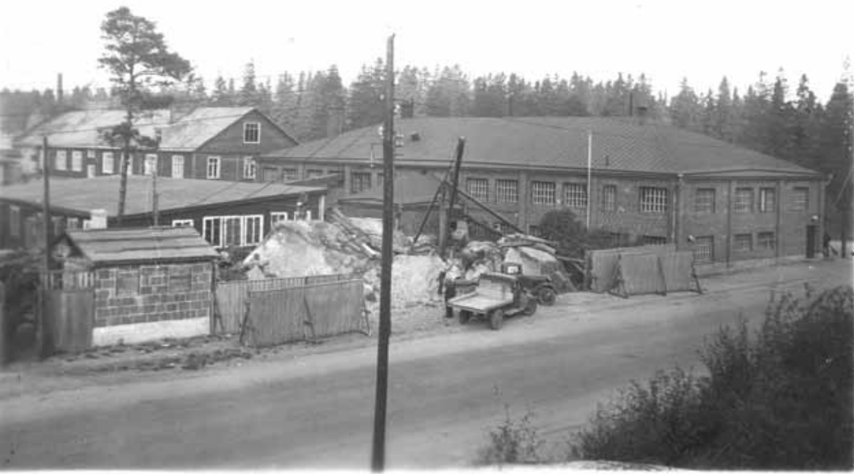
Tehtaan laajennus käynnissä Helsingin Vallilassa 1930-luvun loppupuolella. Uudisrakennuksessa oli heikot eristykset ja aitoa luomurakentamista edustava maalattia, joiden ansiosta se sai työntekijöiltä lempinimen Siperia.
