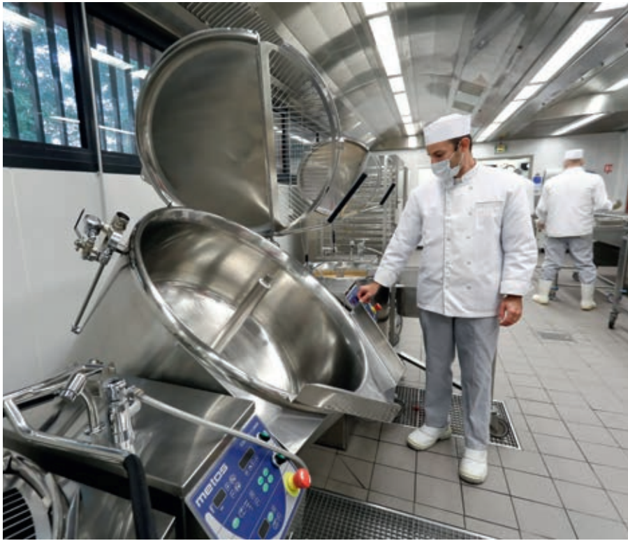
Cuisine entièrement équipée d'équipements multifonction, comme les marmites Metos Culino Combi, limitant le nombre d'appareils de cuisson
